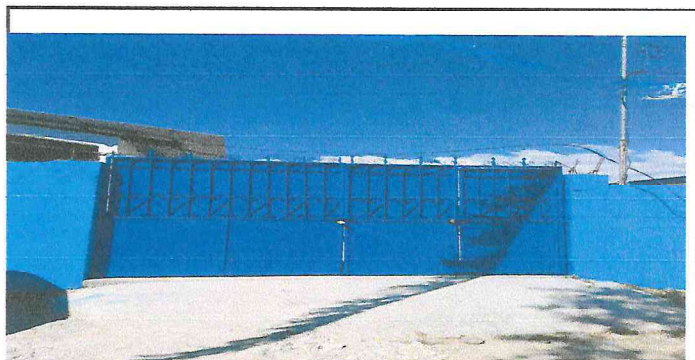
Foto 6: MANTENIMIENTO A PORTÓN
