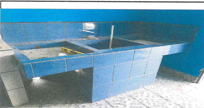
Foto 5: SUSTITUCIÓN DE PILA
